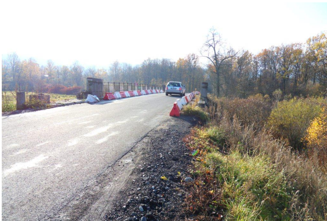
Fot. 22. Bujna wegetacja zieleni wysokiej za obiektem. Braki, uszkodzenia i przemieszczenia separatorów ograniczających skrajnię poziomą na obiekcie. Wypłukana i rozjeżdżona nawierzchnia pobocza z kruszywa kamiennego 0-31,5mm (strona prawa). Przemieszczenia gruntu na skarpie przy dojeździe do obiektu, wegetacja roślinności niskiej i zakrzaczeń na nasypie.
