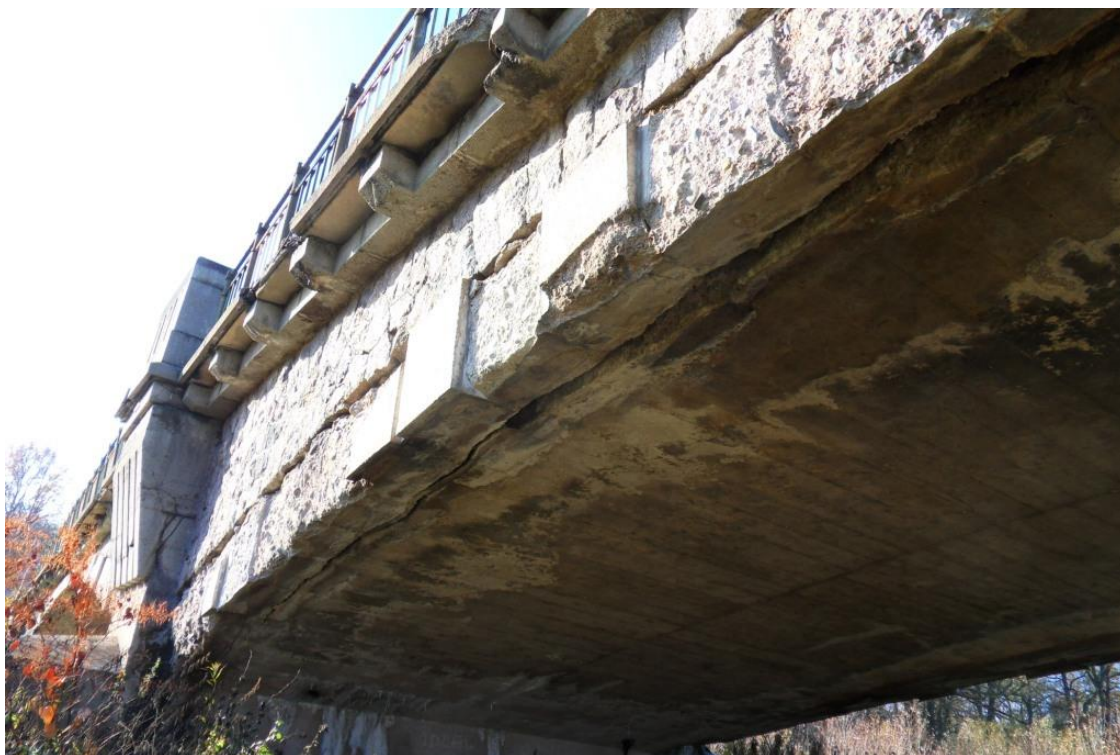
Fot. 3. Intensywne przecieki przez ścianę czołową, wspornik i płytę dźwigara łukowego prawego (górna woda). Odspojenie (pęknięcie kilkucentymetrowe) konstrukcji nośnej łuku wzdłuż podparcia ścianki czołowej pomostu. Spękania, ubytki i braki części bet. łuku. Ubytki beton. elementów balustrad mostowych, korozja odkrytego zbrojenia. Zacieki, osady i wykwity na powierzchni ścian czołowej, wspornika, balustrad i łuku dźwigara. Uszkodzenia łączników i kotew urządzeń obcych mocowanych na obiekcie od strony górnej wody oraz korozja kotew.
