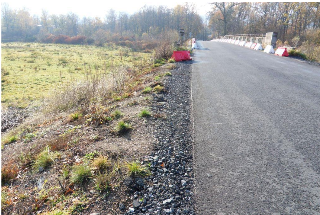
Fot. 21. Braki i przemieszczenia separatorów ograniczających skrajnię poziomą na obiekcie. Wypłukana z kruszywa drobnego nawierzchnia pobocza z kruszywa kamiennego 0-31,5mm (strona lewa). Przemieszczenia gruntu na skarpie nasypu przy dojeździe do obiektu, wegetacja roślinności niskiej.
