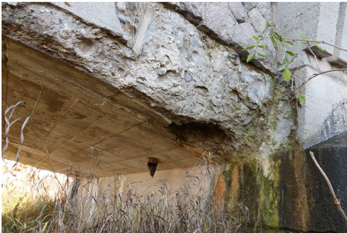
Fot. 5. Intensywne przecieki przez sklepienie betonowe dźwigara i ścianę czołową pomostu. Zacieki, osady i wykwyty na powierzchni łuku dźwigara i przyczółka. Duże ubytki betonu na powierzchni dźwigara betonowego. Zanieczyszczenie i korozja elementów odwodnienia.
