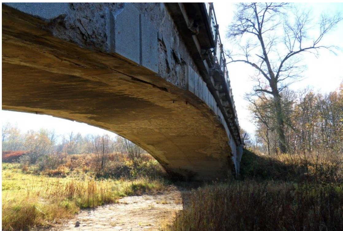
Fot. 15. Intensywne przecieki przez ścianę czołową i płytę dźwigara łukowego lewego (dolna woda). Odspojenie konstrukcji nośnej łuku wzdłuż podparcia ścianki czołowej pomostu. Spękania, ubytki i braki części bet. łuku.
