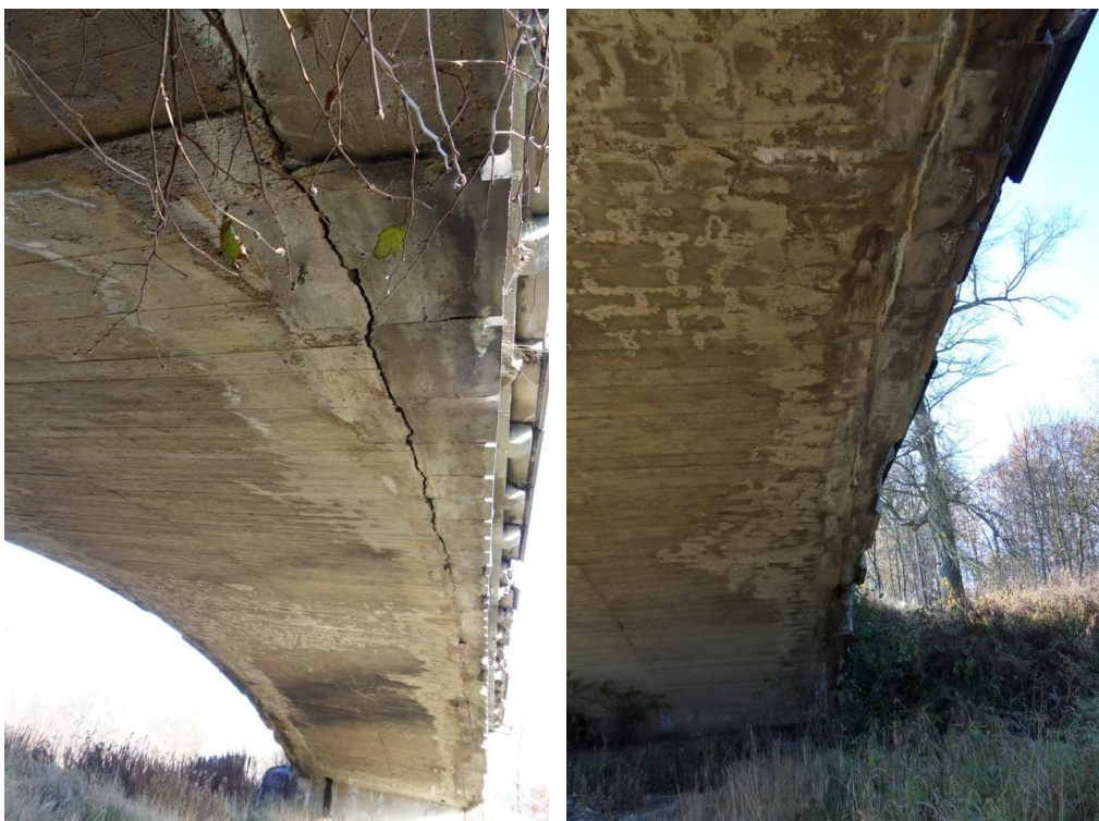
Fot. 17, 18. Obustronne odspojenie konstrukcji nośnej łuku wzdłuż podparcia ścianek czołowych pomostu. Duże zawilgocenie sklepienia betonowego przez niesprawną izolację łuku i odspojenie ścian czołowych (korozja betonu). Zacieki, osady i wykwity na powierzchni sklepienia lewego.
