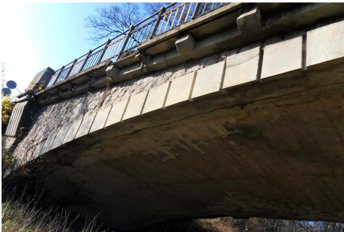
Fot. 16. Intensywne przecieki przez płytę dźwigara łukowego lewego (górna woda). Odspojenie konstrukcji nośnej łuku wzdłuż podparcia ścianki czołowej pomostu. Spękania i ubytki części bet. łuku. Ubytki beton. elementów balustrad, gzymsu i wspornika, korozja odkrytego zbrojenia. Zacieki, osady i wykwity na powierzchni łuku dźwigara i wspornika i gzymsu.
