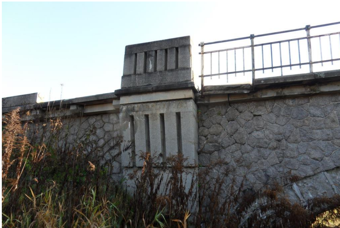
Fot. 11. Ubytki elementów betonowych gzymsu, wspornika i mocowań balustrad (korozja betonu i zbrojenia). Spękania, przemieszczenia i braki betonowych elementów balustrad mostowych nad prawą podporą od str. dolnej wody. Wegetacja roślinności na stożku i skarpach i wzdłuż prawego brzegu koryta polderu.
