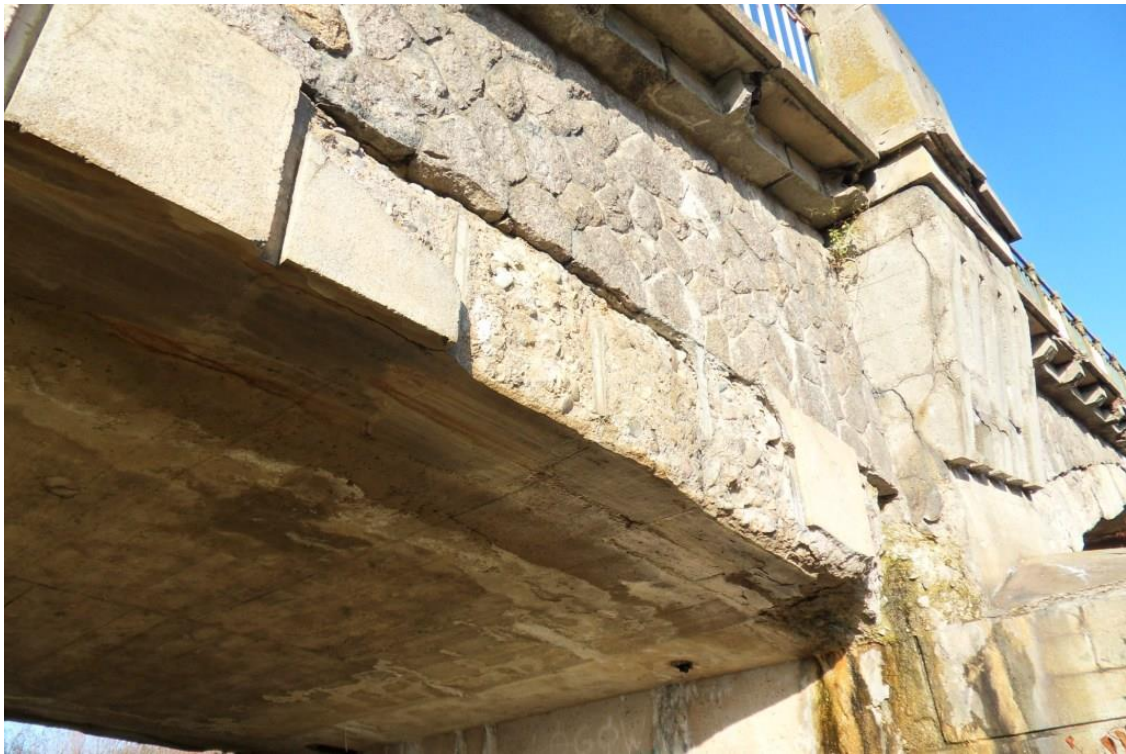
Fot. 12. Intensywne przecieki przez sklepienie betonowe dźwigara i ścianę czołową pomostu.
