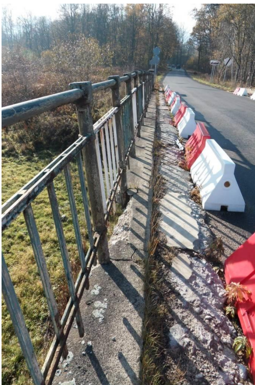
Fot. 25, 26. Korozja balustrad i mocowań stalowych słupków na całym obiekcie. Uszkodzenia gzymsów, opasek betonowych i kątowników stalowych wzdłuż całego obiektu. Braki i przemieszczenia separatorów ograniczających skrajnię poziomą na obiekcie..
