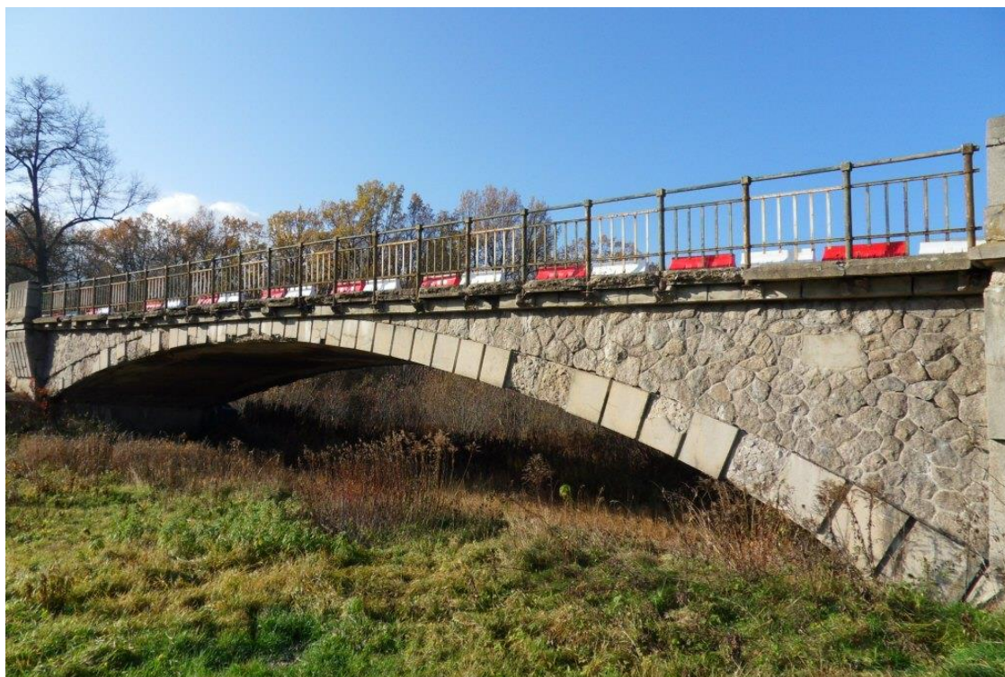
Fot. 9. Brak regulacji powierzchni koryta polderu, nierówności spowodowane nanosem podczas dużej wody. Bujna roślinność niskiej przed obiektem oraz zakrzaczeń i zieleni wysokiej za obiektem. Ubytki elementów betonowych gzymsu, wspornika i mocowań balustrad (korozja betonu i zbrojenia). Korozja balustrady stalowej i kotew mocujących słupki. Ubytki dekoracyjnego wykończenia pow. pionowej łuku.
