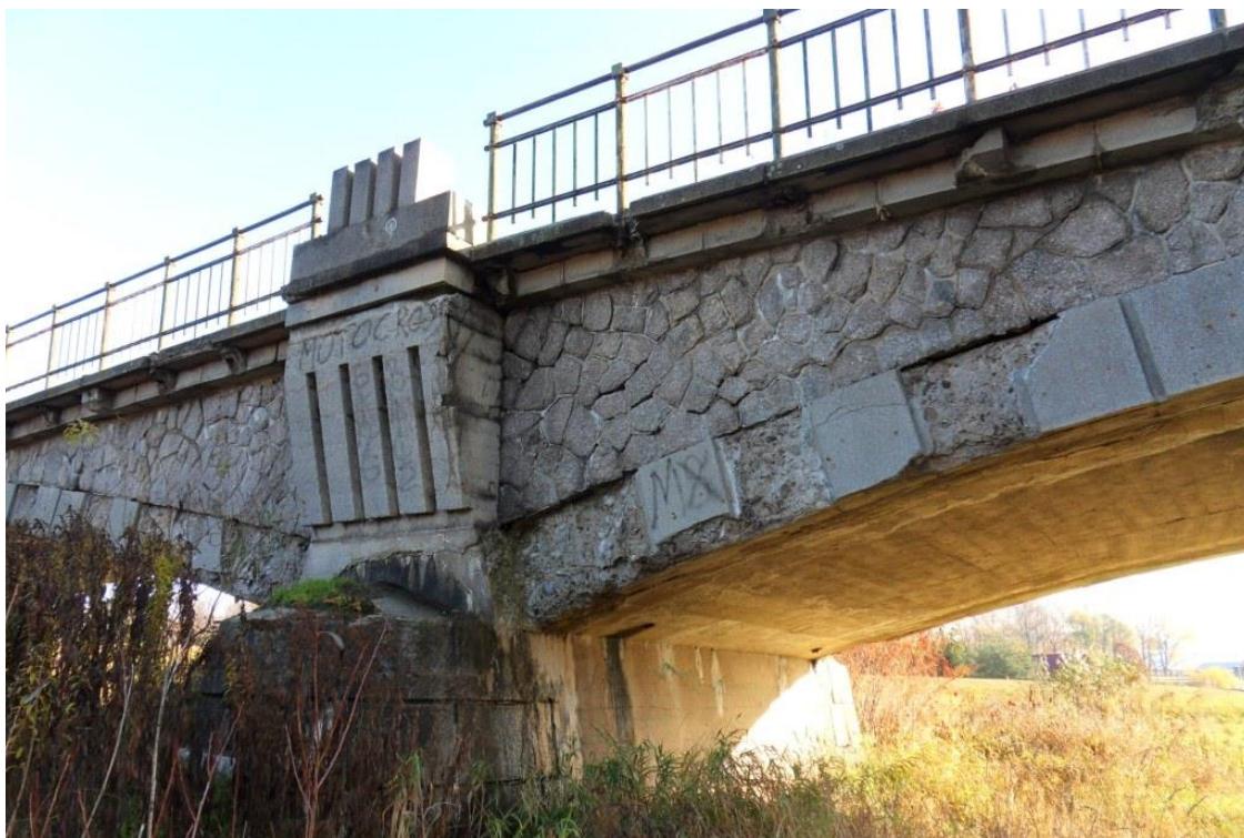
Fot. 14. Spękania, ubytki i braki elementu dekoracyjnego nad filarem (dolna woda). Ubytki dekoracyjnego wykończenia pow. pionowej łuku (bonii). Miejscowe ubytki spoin na konstrukcji kamiennej ścianek czołowych pomostu i filara. Wegetacja roślinności pod i wokół obiektu.
