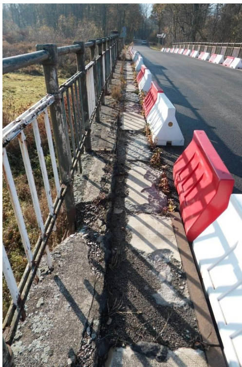
Fot. 25, 26. Korozja balustrad i mocowań stalowych słupków na całym obiekcie. Uszkodzenia gzymsów, opasek betonowych i kątowników stalowych wzdłuż całego obiektu. Braki i przemieszczenia separatorów ograniczających skrajnię poziomą na obiekcie..
