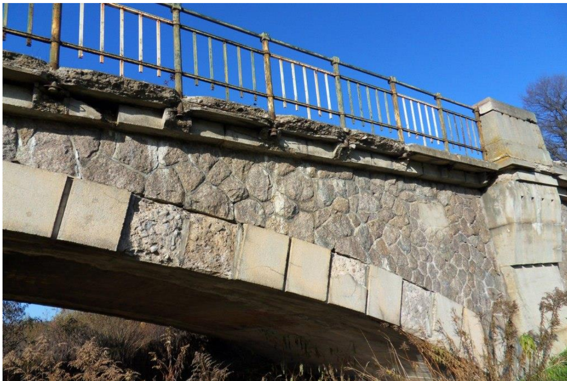
Fot. 8. Ubytki elementów betonowych gzymsu, wspornika i mocowań balustrad (korozja betonu i zbrojenia). Korozja balustrady stalowej i kotew mocujących słupki. Ubytki dekoracyjnego wykończenia pow. pionowej łuku. Zacieki, osady i wykwyty na powierzchni ścian czołowej pomostu prawego przęsła (górna woda).
