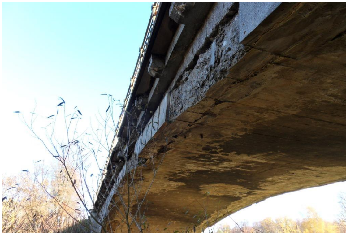
Fot. 4. Intensywne przecieki przez ścianę czołową, wspornik i płytę dźwigara łukowego prawego (dolna woda). Odspojenie konstrukcji nośnej łuku wzdłuż podparcia ścianki czołowej pomostu. Spękania, ubytki i braki części bet. łuku. Ubytki beton. elementów balustrad mostowych, korozja odkrytego zbrojenia. Zacieki, osady i wykwity na powierzchni ścian czołowej, wspornika, balustrad i łuku dźwigara.
