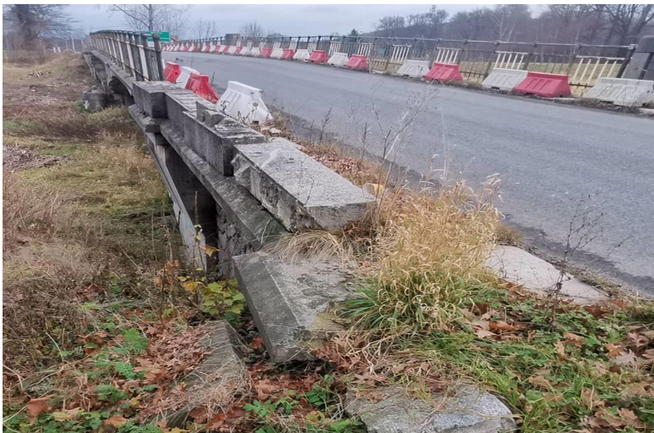
Rys. 3.4 Widok na zdegradowane betonowe balustrady na skrzydłach
