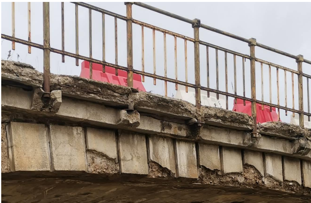
Rys. 3.5 Widok na zdegradowane kapy chodnikowe i płyty elewacyjne sklepienia
