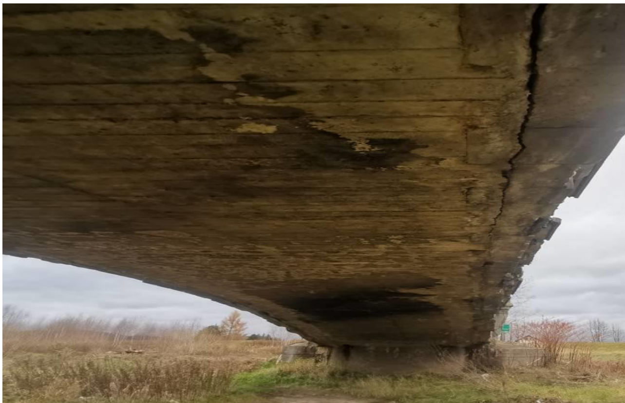
Rys. 3.2 Widok na odspojone sklepienie
