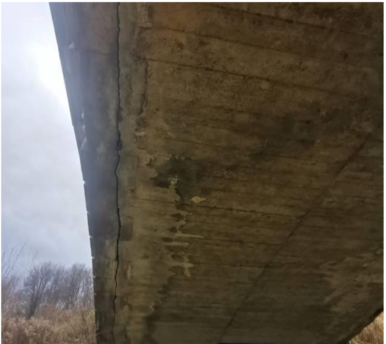
Rys. 3.1 Widok na odspojone sklepienie
